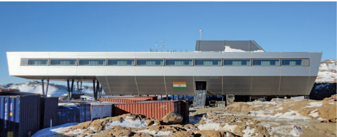
Die indische Forschungsstation „Bharati“ kurz vor der Fertigstellung: Sandwichelemente aus organisch beschichtetem Zink-Magnesium-veredeltem Feinblech erfüllen höchste Anforderungen auch bei Temperaturen bis zu minus 45 °C
